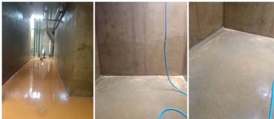
ภาพที่ 4-40 ล้างทำความสะอาดถังสำรองน้ำใช้
