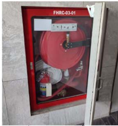
ภาพที่ 4-17 ตู้เก็บสายฉีดน้ำดับเพลิง
